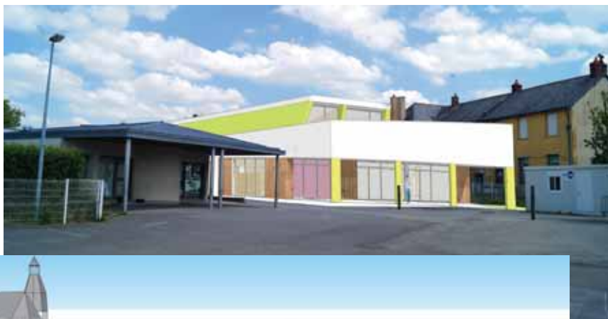
Vue de la cour de l'ancienne maternelle.
