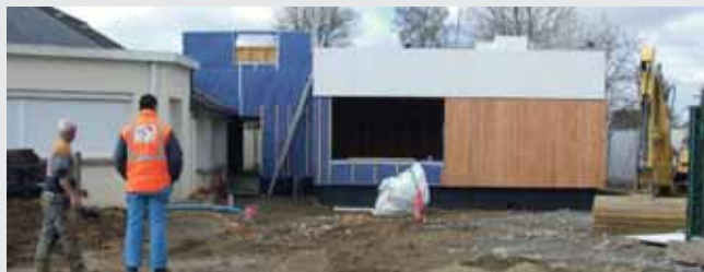
Une vue du chantier à la mi-avril.
