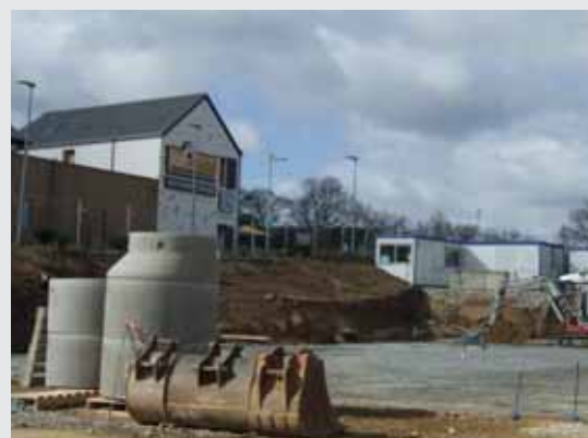
Les travaux ont débuté au Drive Leclerc en mars à proximité du restaurant Ker Soazig.
