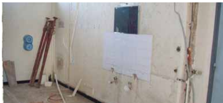
État du chantier au 16 février.
