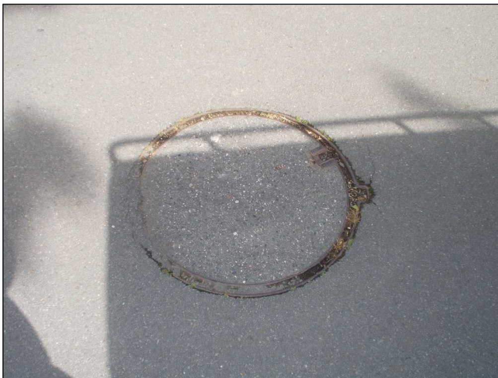
Photo 5 : Vue d'un tampon situé en partie sous enrobé
