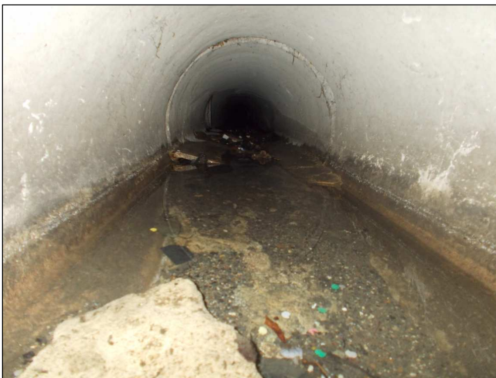
Photo 4 : Vue d'un réseau à curer – Rue Macéria
