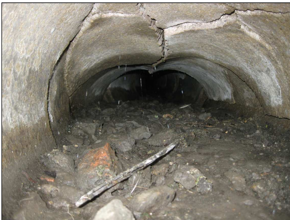
Photo 6 : Vue d'un affaissement de réseau – Rue de Texue
