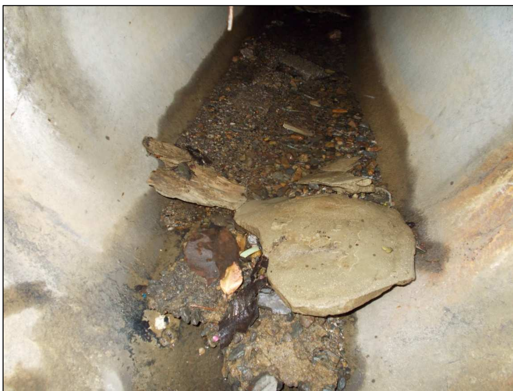
Photo 2 : Vue d'un réseau à curer du lotissement « Le Domaine de la Fontaine »
