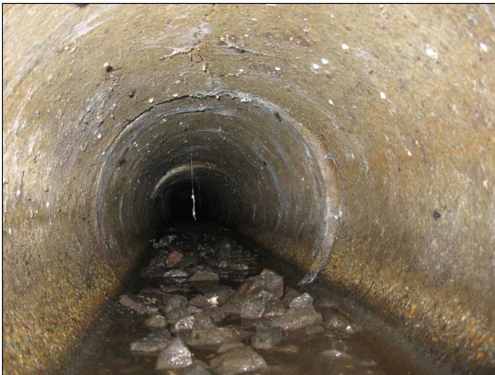
Photo 3 : Vue d'un réseau à curer - Rue de Texue
