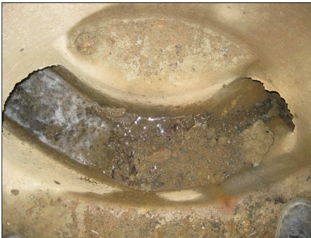
Photo 7 : Vue d'un mauvais rejet type machine à laver
