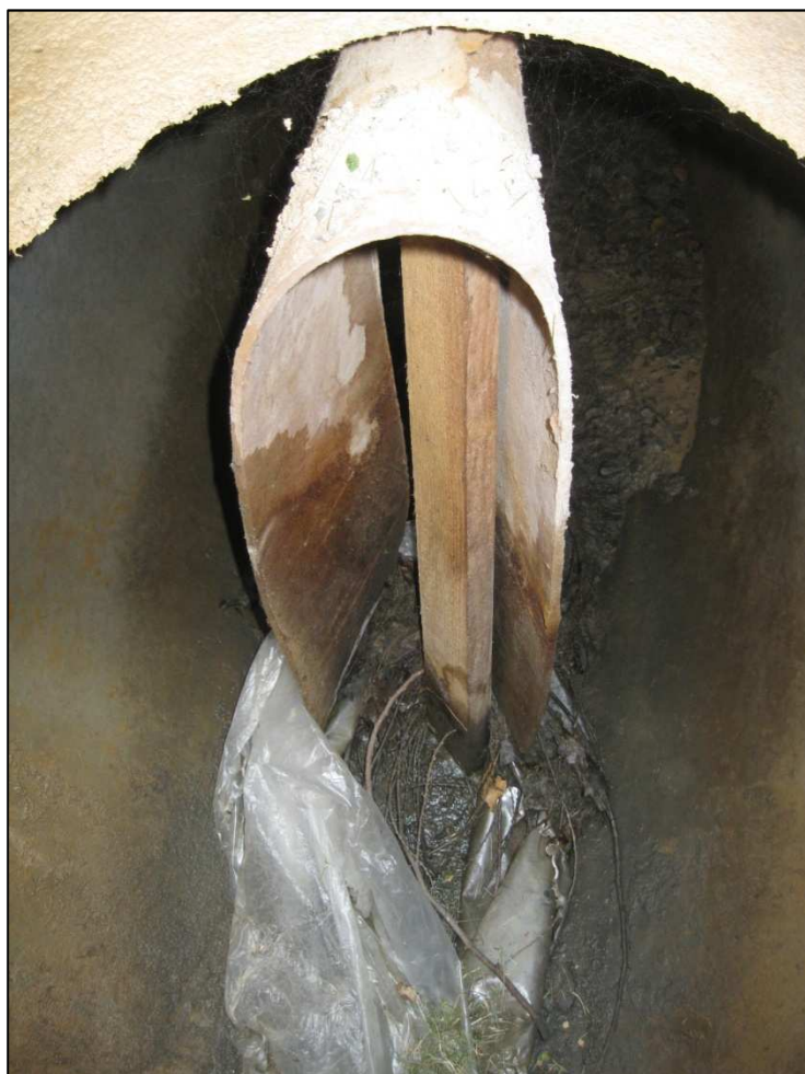
Photo 8 : Vue d'un coffrage oublié dans un réseau Ø800 – Route de Rennes
